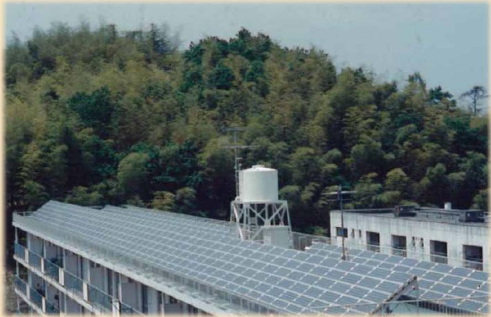
太陽電池容量22.2kW、20戸に給電、半導体SWを用いた系統連系
