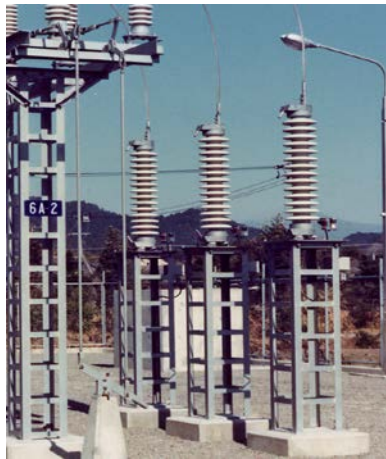
世界初の酸化亜鉛形避雷器九州電力隼人 SS
