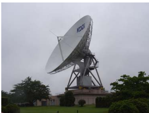
旧茨城衛星通信センターのカセグレアンテナ (現在は電波天文用として使われている)
